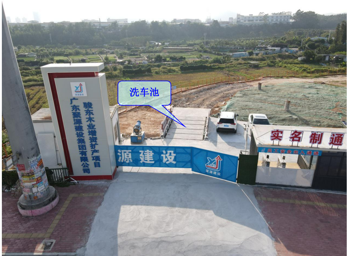
照片2 项目施工出入口
