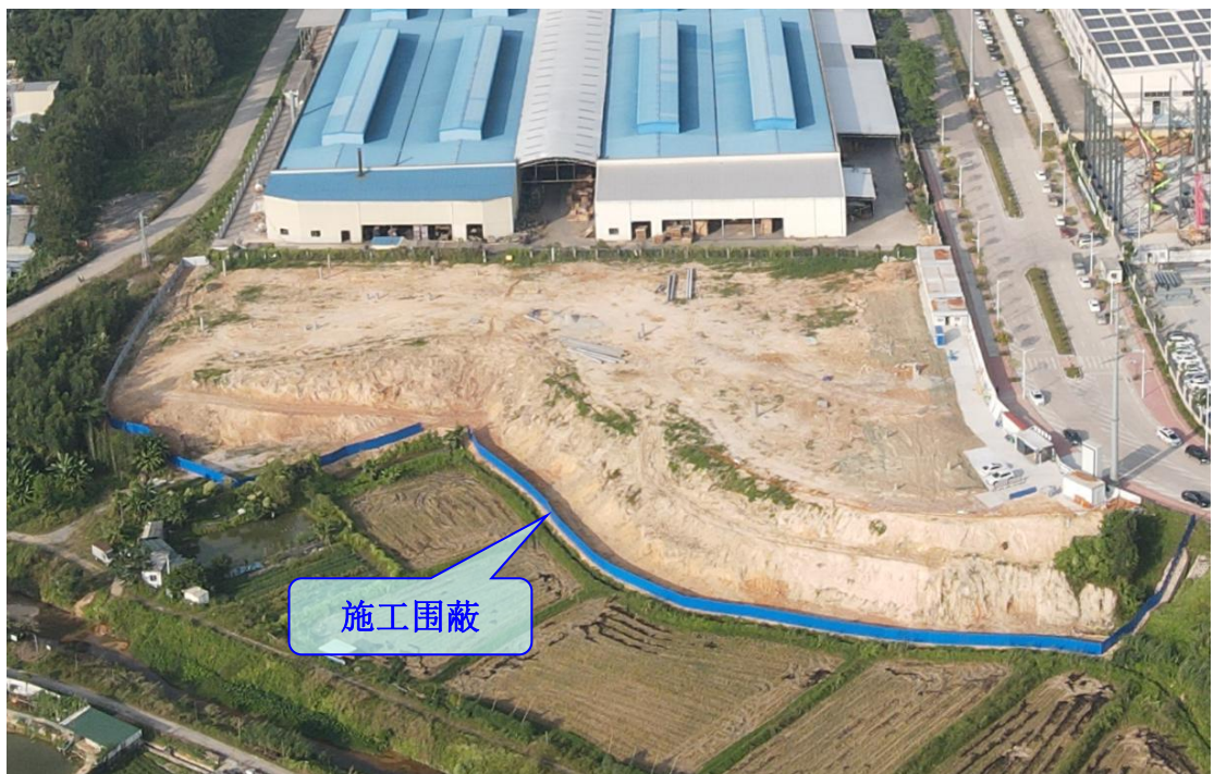
照片3 项目整体施工现状
