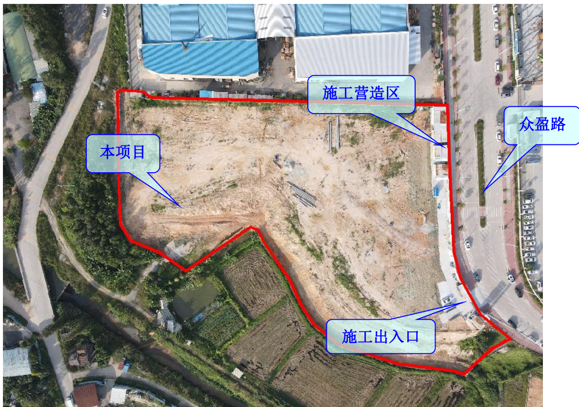
照片1 项目整体施工现状
